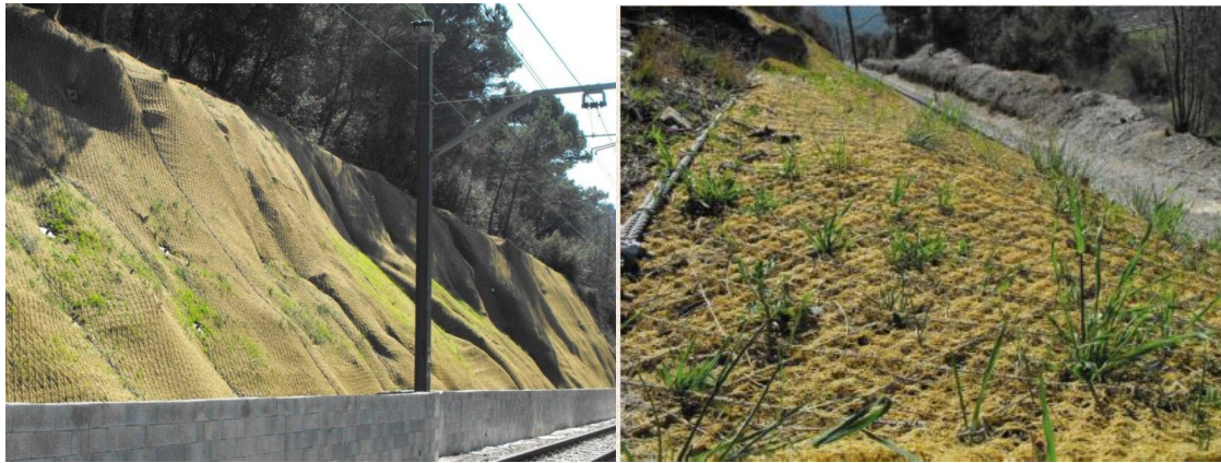
Slika 2.10. Upotreba biorazgradivog Greenax® geotextila za prevenciju erozije tvrtke Geobruugg načinjenog od PLA i PBS
