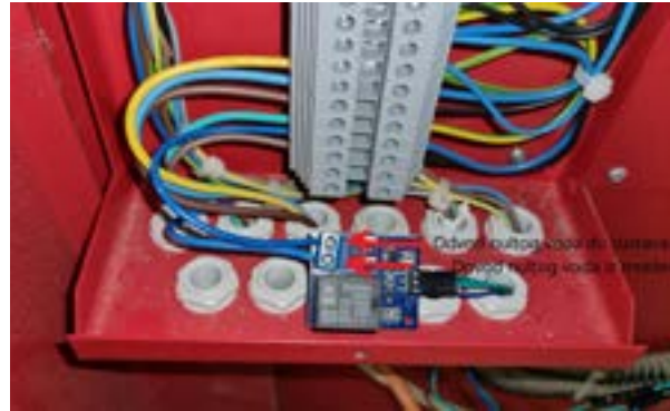
Slika 12 Spajanje nultog voda centralnog grijanja [1];
