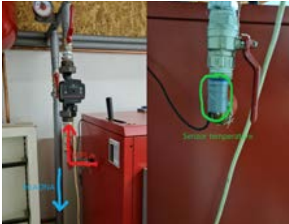
Slika 10 Postavljanje senzora temperature [1];
