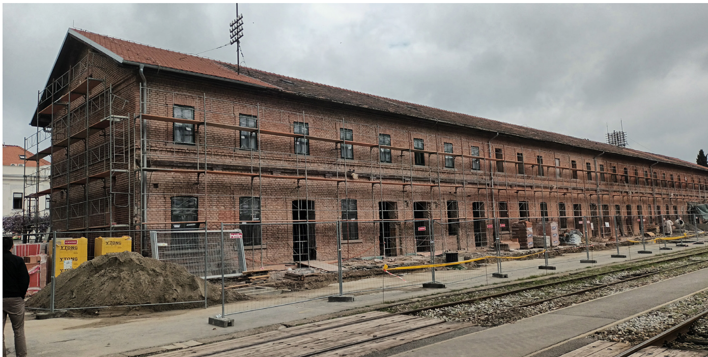
Slika 5. Izvođenje radova na prijamnoj zgradi željezničkoga kolodvora Osijek
