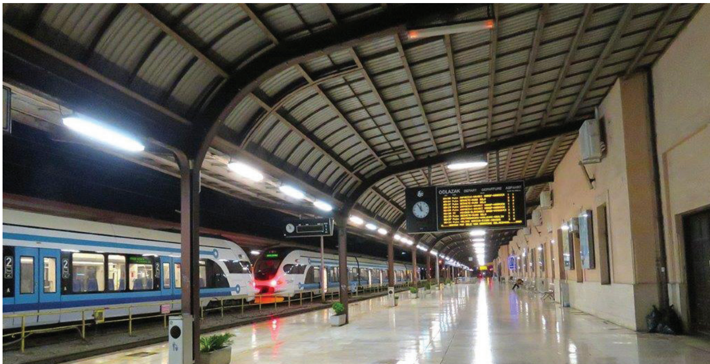
Slika 9. Postojeća nadstrešnica I. perona Zagreb Glavnog kolodvora
