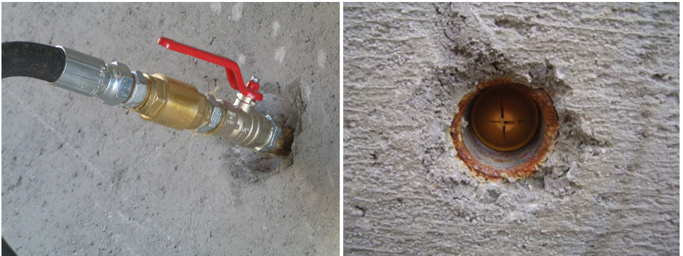
Slika 7. Prikaz tvornički ugrađenoga priključka za ubrizgavanje bentonita (unutar i izvan cijevi)
