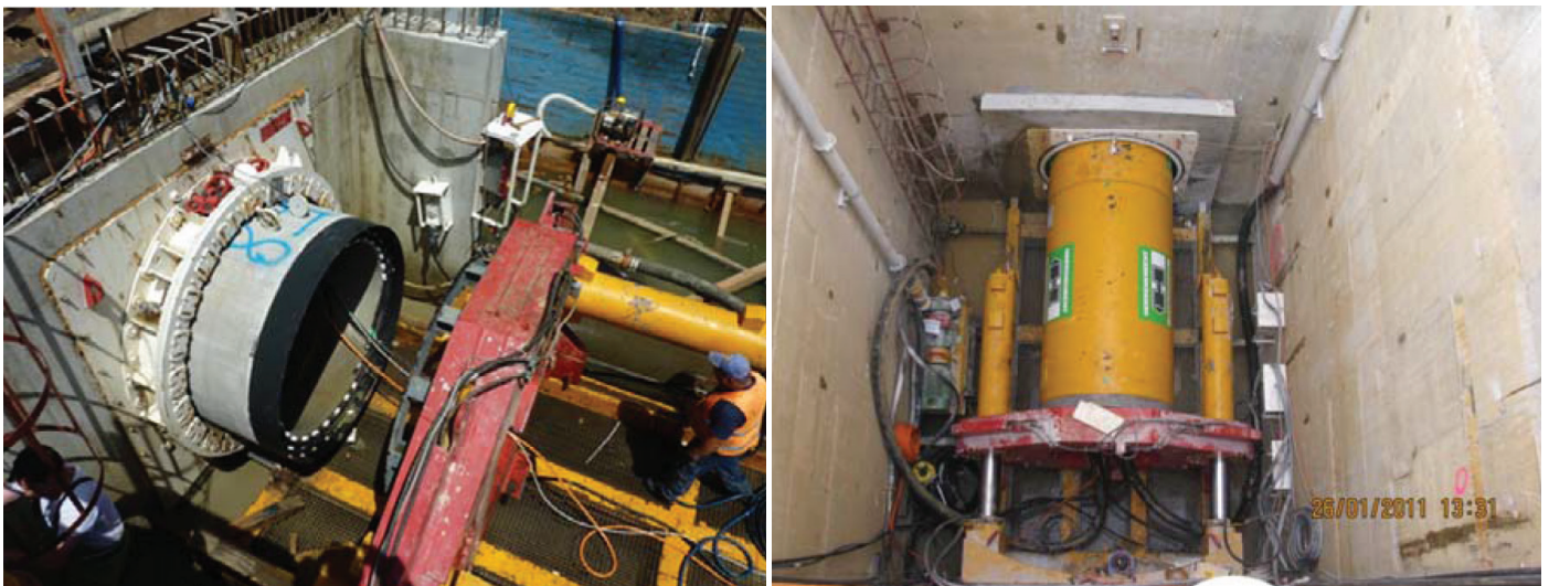
Slika 3. Startna jama mikrotuneliranja
