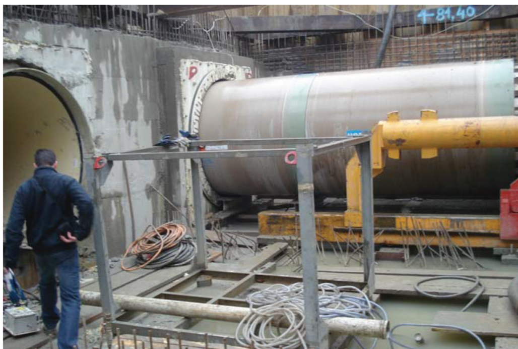
Slika 14. mikrotuneliranje - željeznički propust s ugrađenim poliesterskim cijevima
