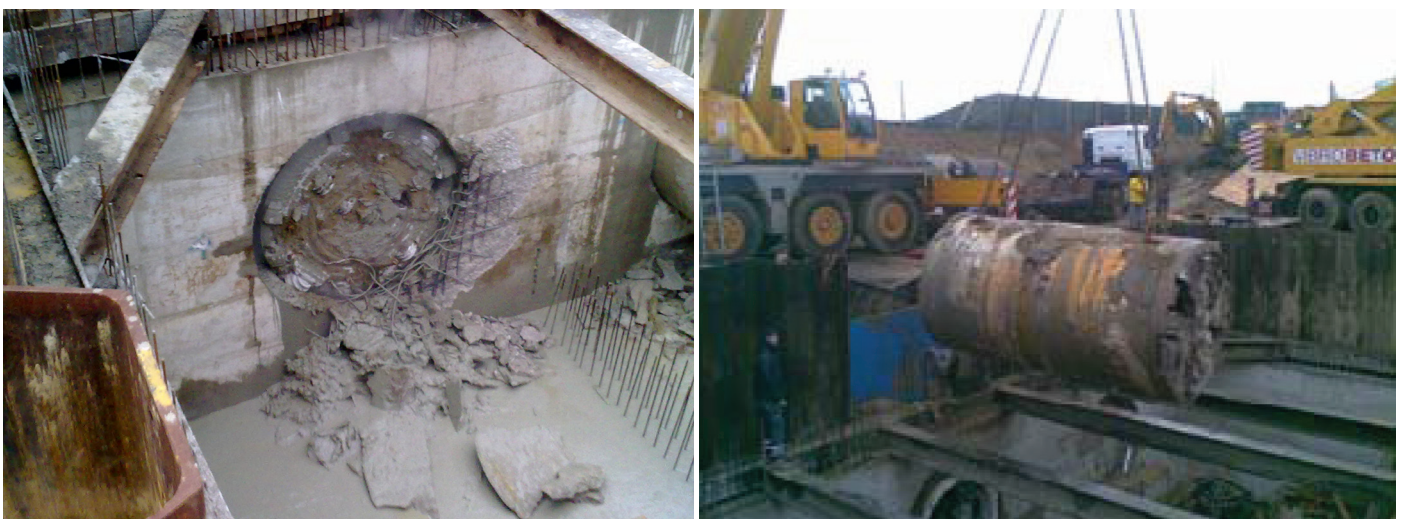
Slika 4. Probaj tunela – bušenje stijenke zida izlaznoga okna / vađenje stroja za mikrotuneliranje
