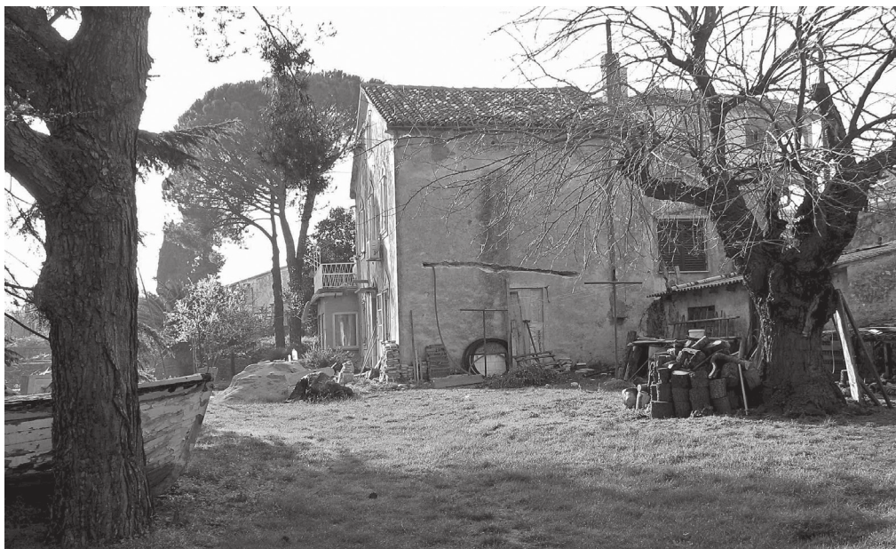
Sl. 2. Grad Krk, kuća Schinigoj, pogled na istočnu fasadu ispred koje se kriju arheološki ostaci crkve Sv. Lovre, Fototeka Ministarstva kulture, Uprave za zaštitu kulturne baštine, Konzervatorskog odjela u Rijeci (foto: D. Krizmanić, 2012.)
