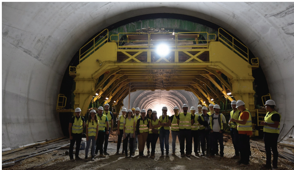
Slika 4. Studenti ispred pokretne oplata izrađene specijalno za gradnju tunela Podmurvice.
