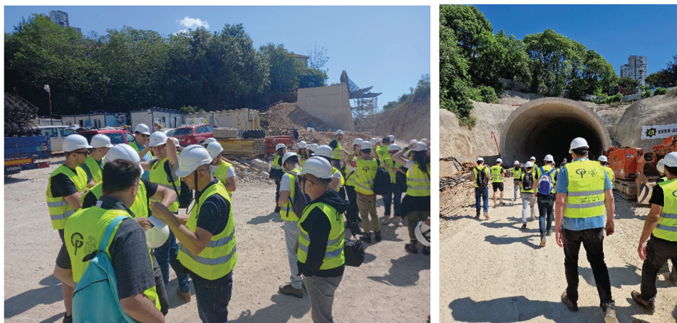
Slika 3. Priprema za ulazak na gradilište.
