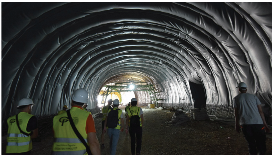
Slika 5. Dio tunela s ugrađenom hidroizolacijom.
