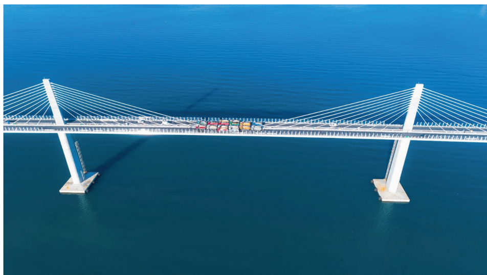
Slika 7. Ispitivanje središnjeg raspona R7, 16 kamiona ukupne mase 640 t.
