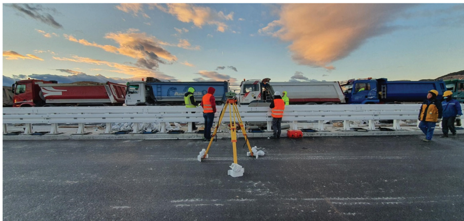
Slika 10. Učvršćivanje stativa nivelira zbog zaštite od udara vjetra.
