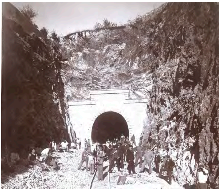
Slika 4. Završni radovi na ulaznom portalu.
