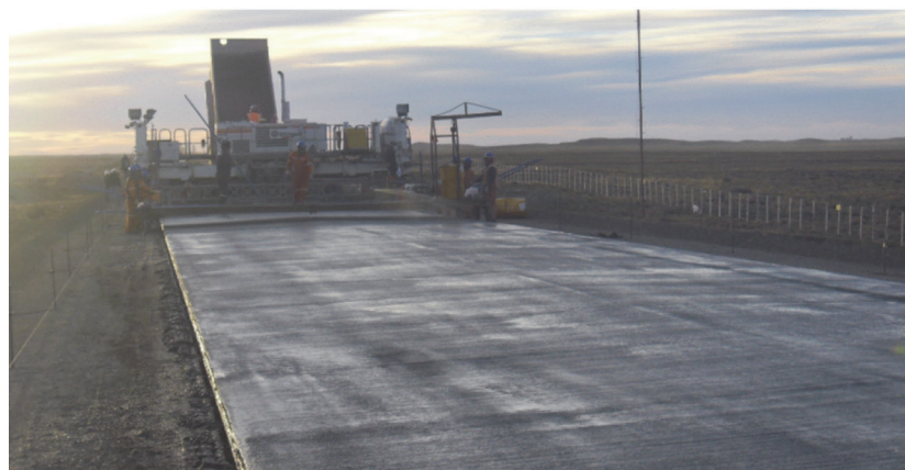
Slika 6. Popločavanje slipformerom (lijevo) i (rano) piljenje poprečnih razdjelnica (desno) na međugradskom JPCP-u s kratkim pločama [19]
