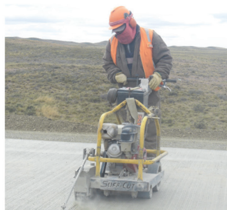
Slika 6. Popločavanje slipformerom (lijevo) i (rano) piljenje poprečnih razdjelnica (desno) na međugradskom JPCP-u s kratkim pločama [19]
