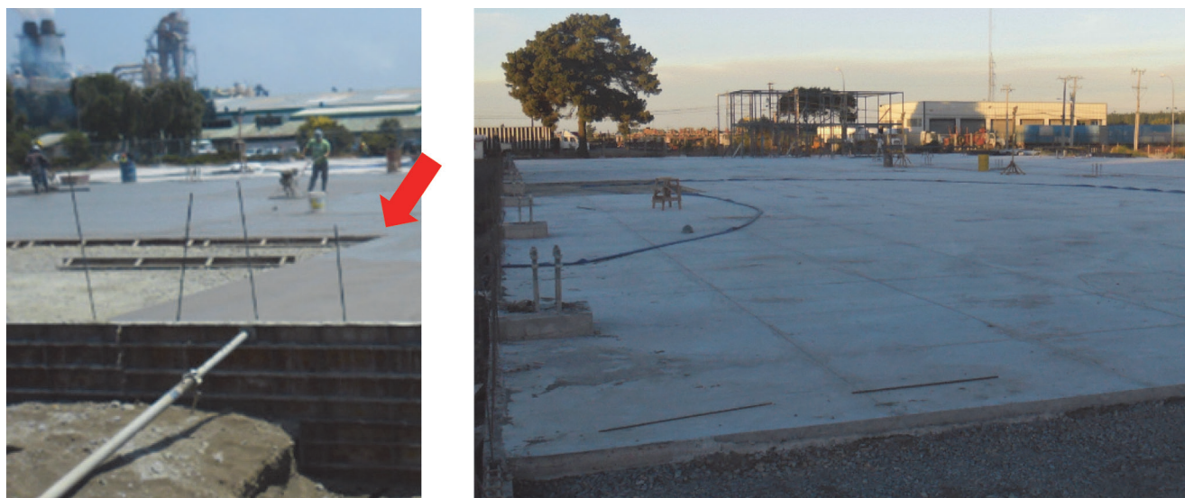
Slika 7. Izrada industrijskog poda s kraćim nepravilnim dionicama (lijevo) i pogled na industrijski pod (desno) [19]
