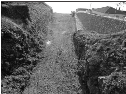
Sl. 12. Kolan nakon završenih građevinskih radova početkom svibnja 2022. (foto: Gradski muzej Senj, 2022.)
