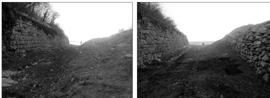
Sl. 6. a) i b) Ušće Kolana prije građevinskih radova (foto: Gradski muzej Senj, 2022.)
