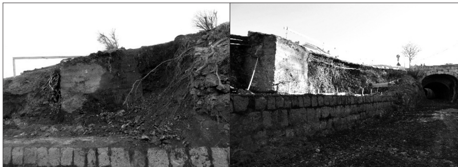
Sl. 13. a) i b) Snimak recentnog betonskog zida u profilu desne obale ušća Kolana (foto: Gradski muzej Senj, 2022.)
