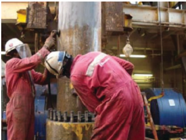
Slika 10. Uklanjanje korozije s unutarnje cijevi i tretiranje zaštitnim premazom (Upton, 2009)
