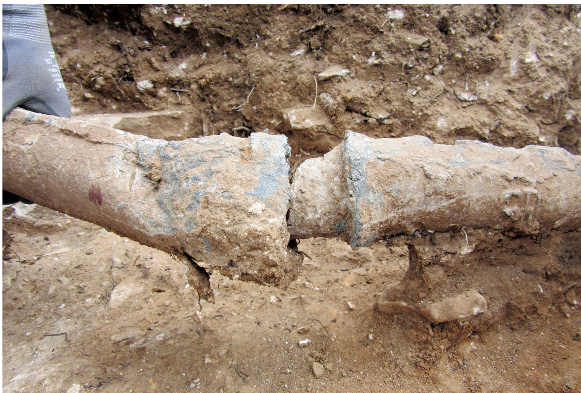
SLIKA 9. Detalj spoja dviju vodovodnih cijevi (foto: T. Šalov) FIGURE 9 Connection of two water pipes, detail (photo: T. Šalov)
