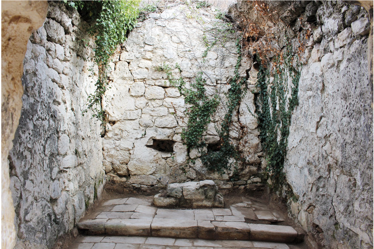
SLIKA 7. Istražena unutrašnjost crkve – pogled prema prezbiteriju (foto: Ž. Miletić; © DisKont) FIGURE 7 Excavated church interior – view towards the chancel (photo: Ž. Miletić; ©DisKont)
