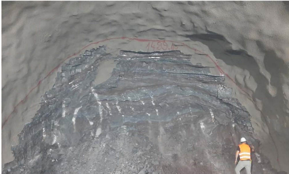
Slika 2. Prikaz čela radilišta, stacionaža 1+499,10 - lijeva tunelska cijev
