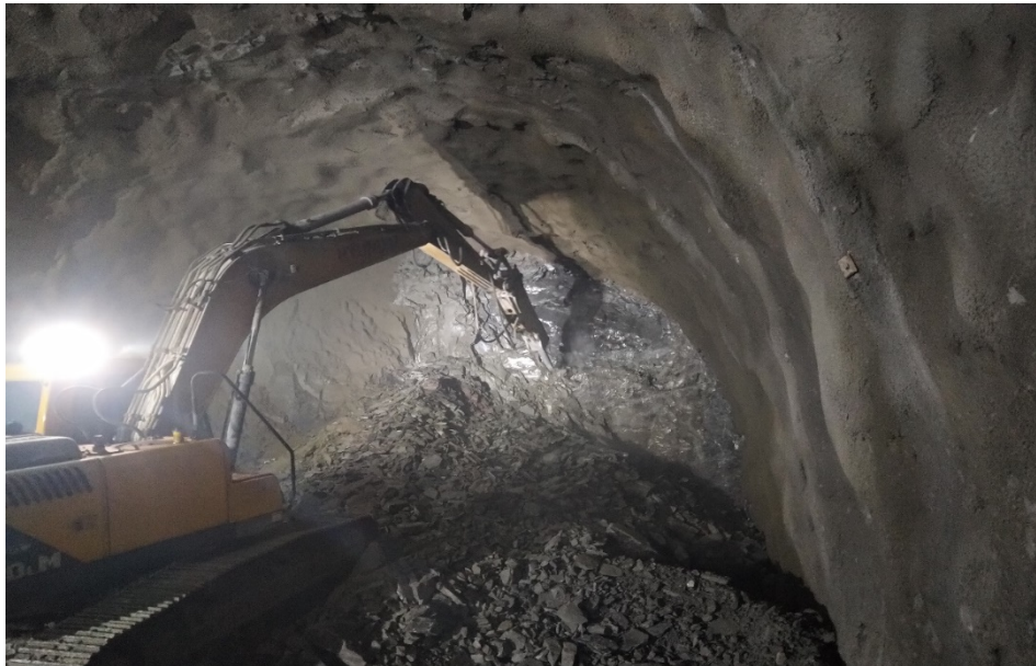
Slika 6. Strojni iskop punog profila u LTC na stacionaži 1+518,00 do 1+520
