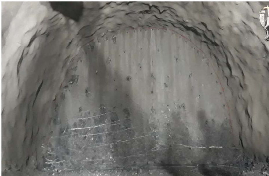
Slika 9. Profil čela LTC na stacionaži 1+522.08 nakon završetka bušenja svih bušotina za miniranje po definiranoj shemi
