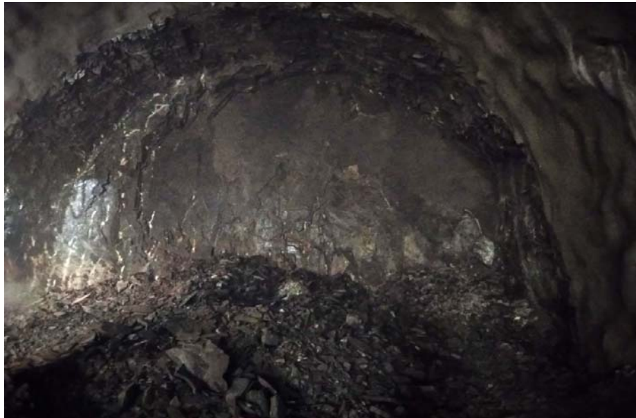
Slika 10. Profil čela LTC na stacionaži 1+524.088 nakon provedenog miniranja i obrade profila
