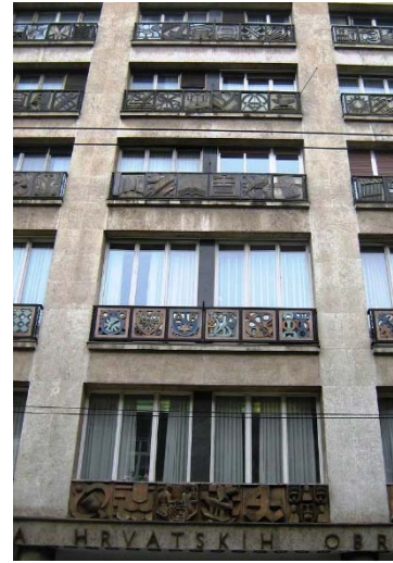
Slika 13. Fotografija glavnog pročelja Matice hrvatskih obrtnika s ogradama dekoriranim pločama. Autor: Cela Matan
