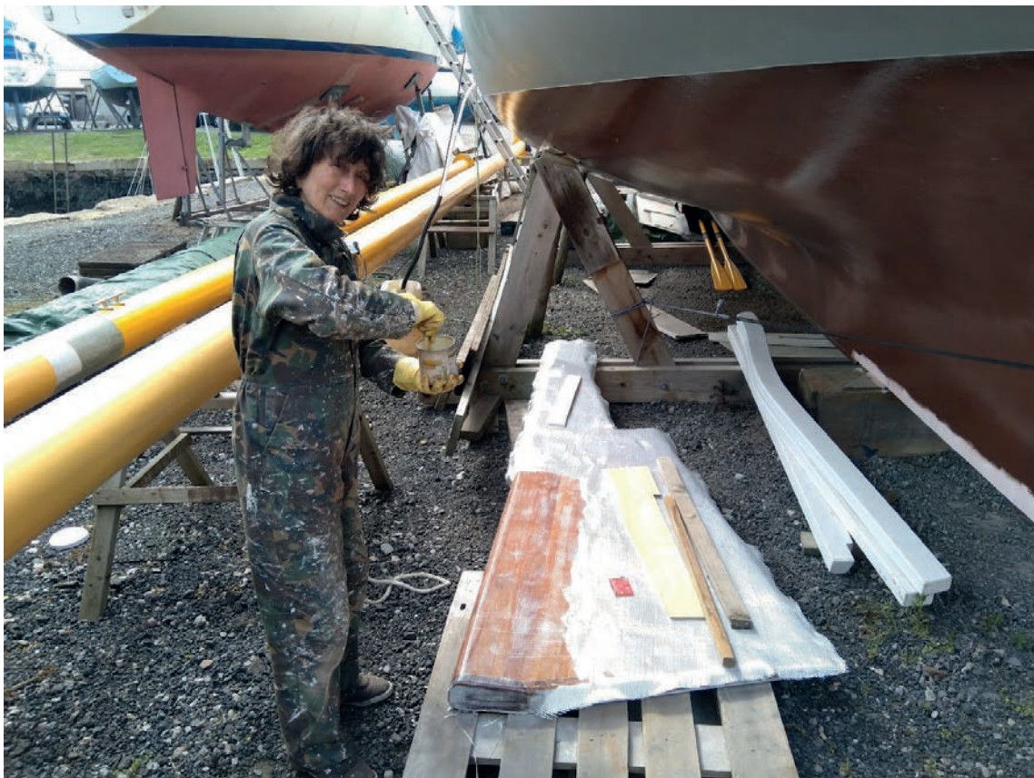
Rad na novom domu – brod „Kokachin“. Foto: Pete Hill
