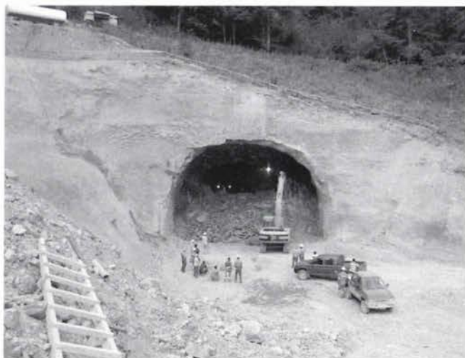
Slika 11. Istočni portal – nakon miniranja posljednjih 4,5 metara očekivan je proboj, no on je uslijedio tek nakon upotrebe 10-tonskog pneumatskog čekića s unutrašnje strane (tunel je bušen samo sa zapadne strane).
