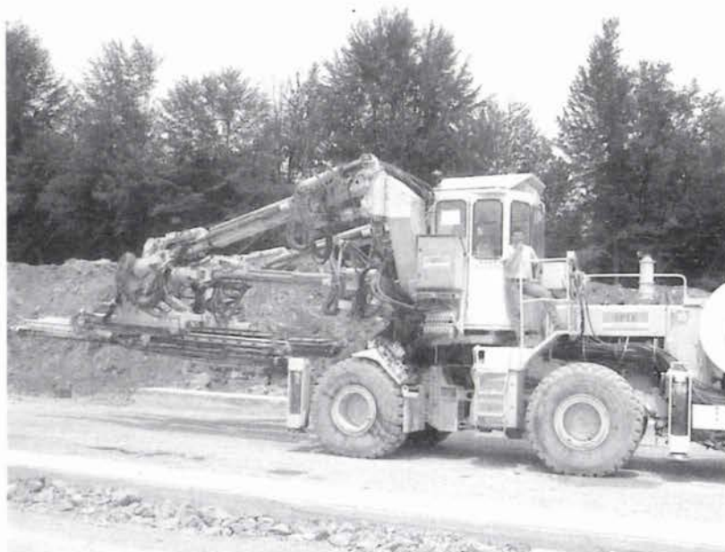
Slika 3. Robofor upotrijebljen na probijanju tunela Veliki Gložac.
