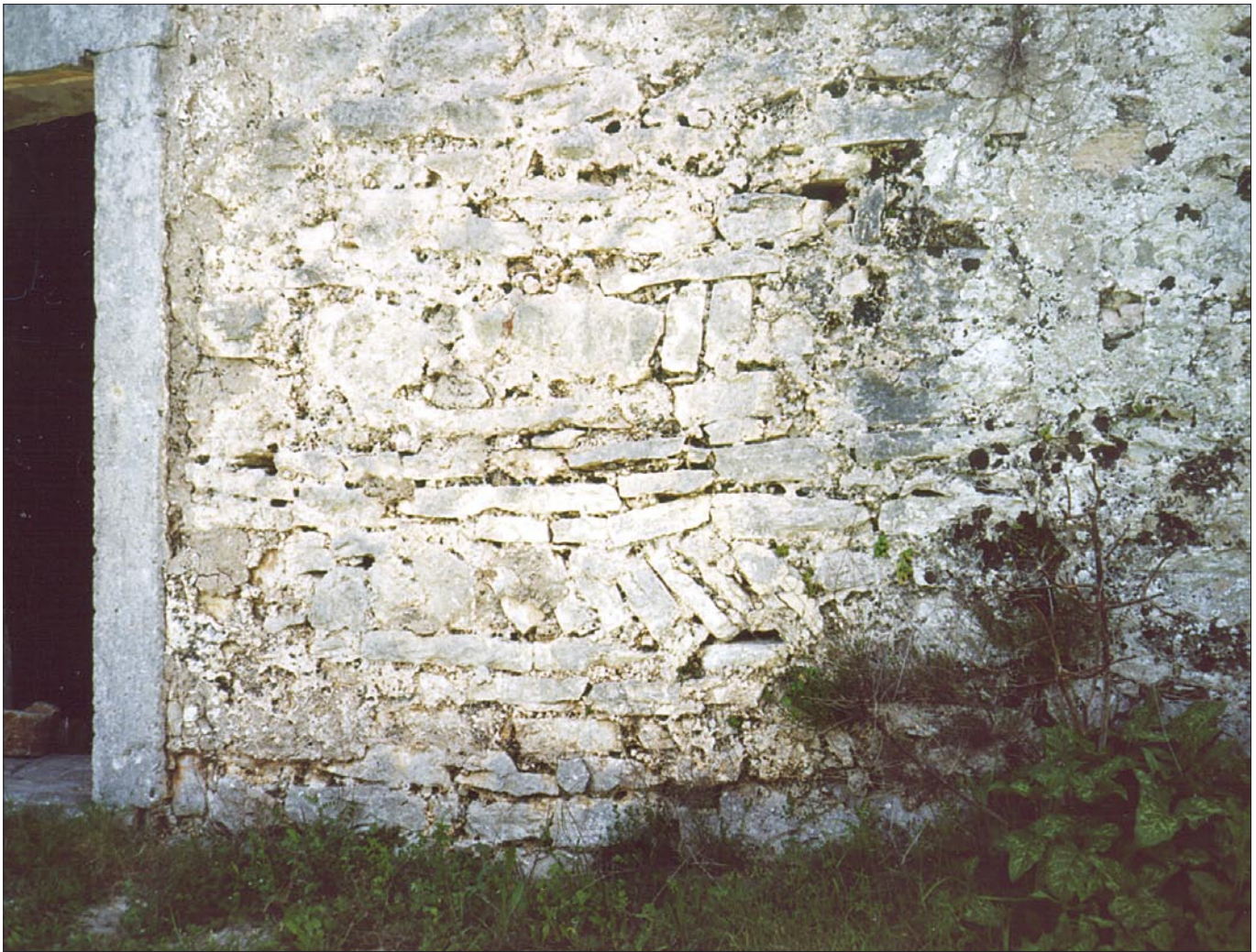
Slika 5. Pogled na južni dio pročelja
