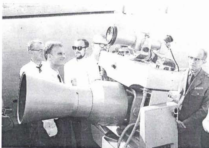
Slika 4. Fotografska pomična četvero-osna kamera za praćenje gibanja umjetnih Zemljinih satelita AFU-75
