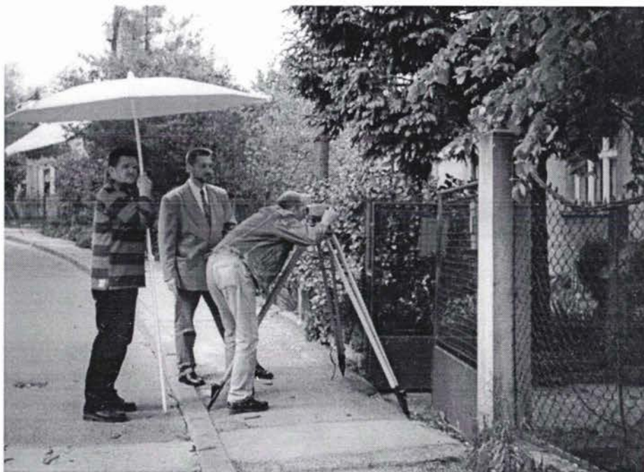
Slika 2. Priključak na visoki reper s rupicom
