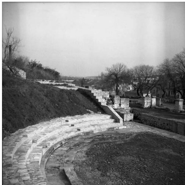
Sl. 25 Pogled na sjeverni dio kazališta nakon zahvata 70-ih godina. Zanimljiv je detalj u donjem lijevom uglu fotografije gdje je još uvijek vidljiv ostatak kamene ograde in situ, koja je dijelila gledalište od orkestre (fotografija: Š. Mlakar, Dokumentacijski odjel AMI).
