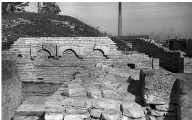
Sl. 7 “Pogled na krunu vanjskog zida desnoga paradosa (načinjena ljeti 1949.) i lukove balkonske lože, rađene 1933. i uzidane u VI/VII mj. 1939. lijevo od prolaza - cliva.” (fotografija: nepoznati autor, Dokumentacijski odjel AMI). Fig. 7 “View of the top of the outer wall of the right side parodos [aditus maximus] (shot taken in 1949) and the arches of the balcony loggia, done in 1933 and walled up in June/July of 1939 left of the passage/incline.” (photo by: anonymous, AMI documentation department).
