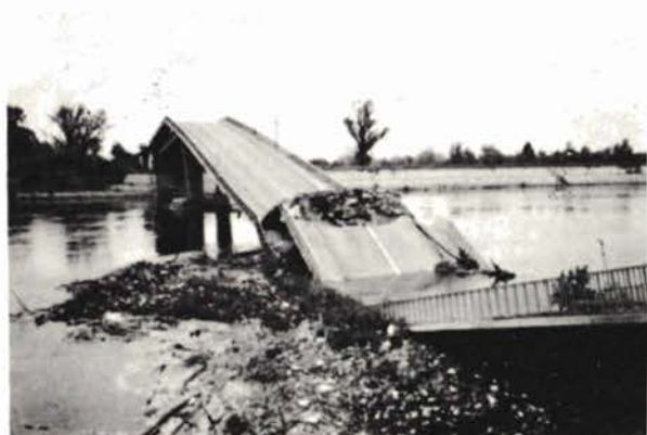
Slika 3. Oštećeni most u Domovinskom ratu 1991. g.
