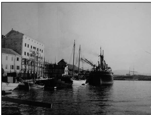
Sl. 16. Pristanište Vruļje uz novosagrađenu zgradu Carinarnice 1938. godine.
