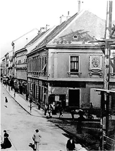
6 Fotografija Ilice kod križanja s Frankopanskom ulicom na kojoj se vide skele kuće u izgradnji, 1894. Photograph of the corner of Ilica and Frankopanska streets at the time of the building's construction with visible scaffolding, 1894
