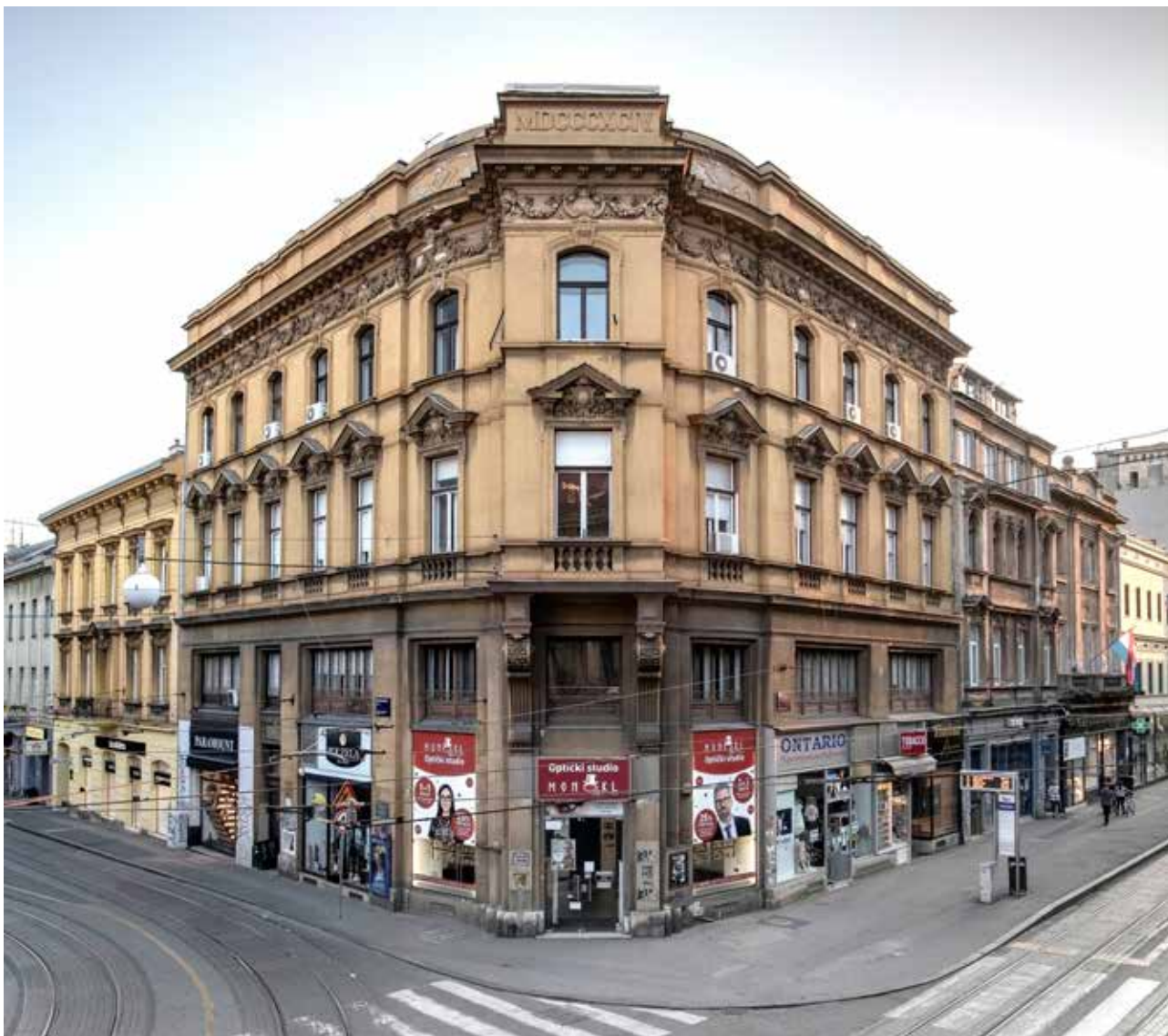
18 Pročelje bez tornja, rujan 2021. (foto: J. Kliska)
