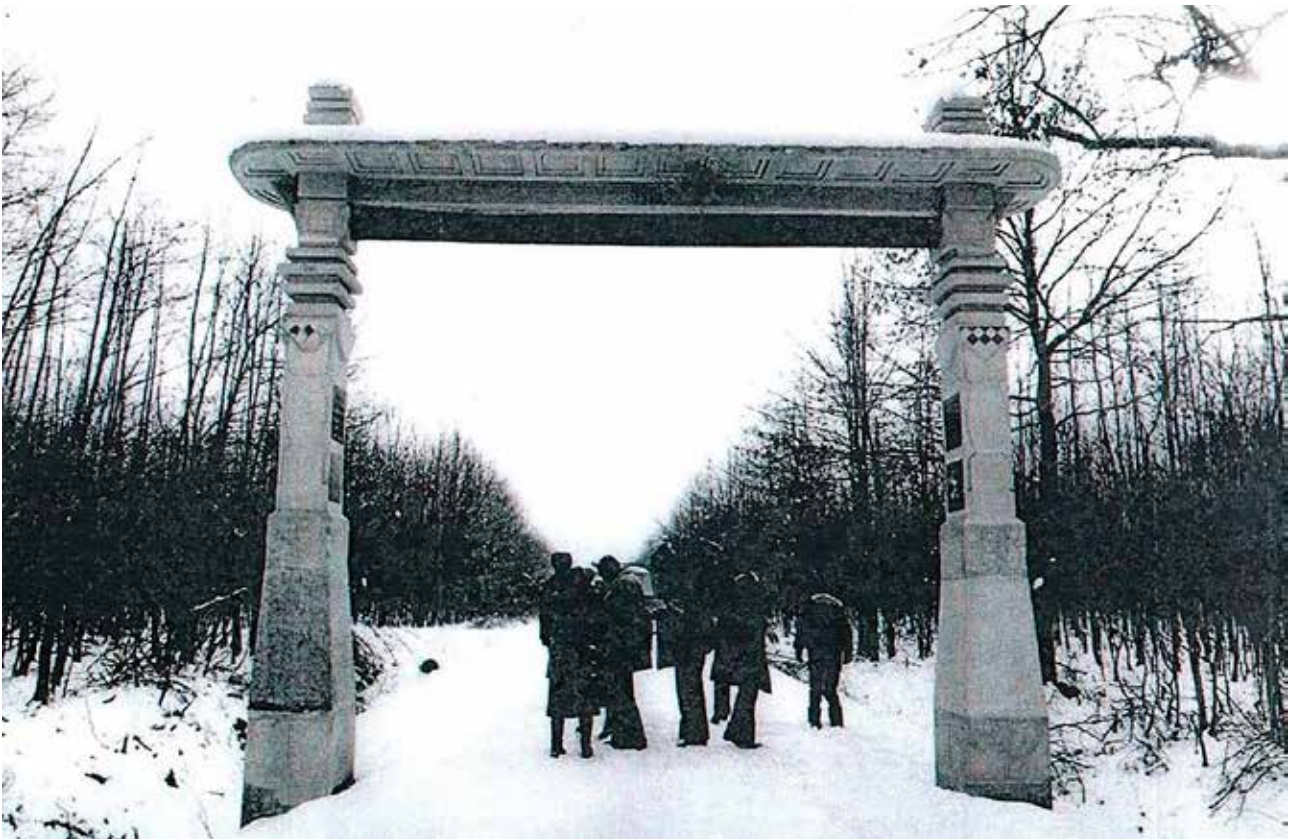
7 Vrata od krča, stanje nakon obnove 1983. (foto: HRZ, AKO-ZG, 1984.)
