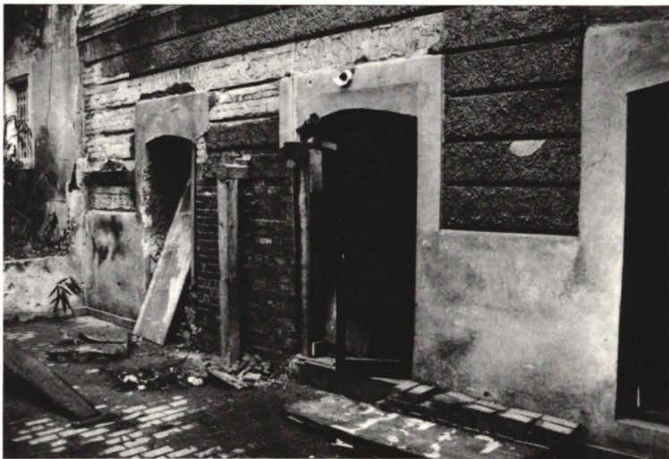
Sl. 15. Obnovljeni zid na mjestu pogotka rakete u temelj (visoka 14 a)
