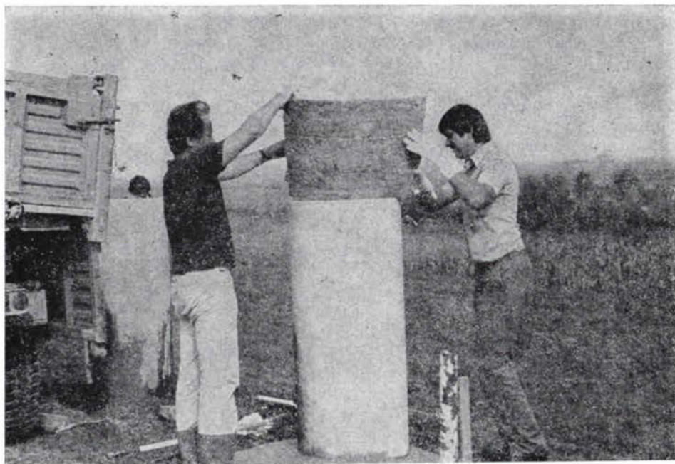
Slika 12. Postavljanje staklene vune u cijevi (u kojima je tada bila samo željezna armatura)
