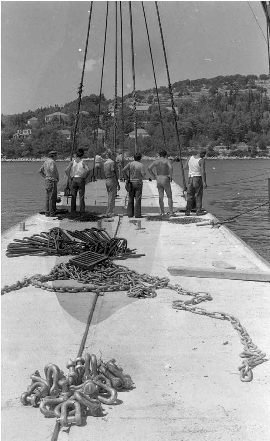
HR-DADU-SCKL-691/6.005. Polaganje bloka trajektnog pristaništa u Veloj Luci (oko 1979.)
