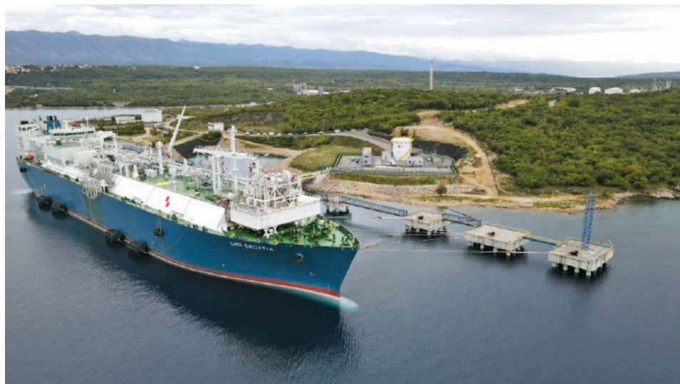
Slika 1. Terminal za UPP, Omišalj
