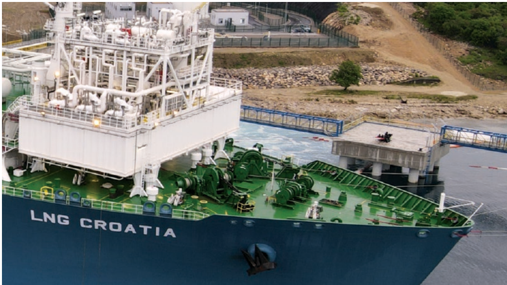
Slika 2. Modul za uplinjavanje, FSRU „LNG Croatia“
