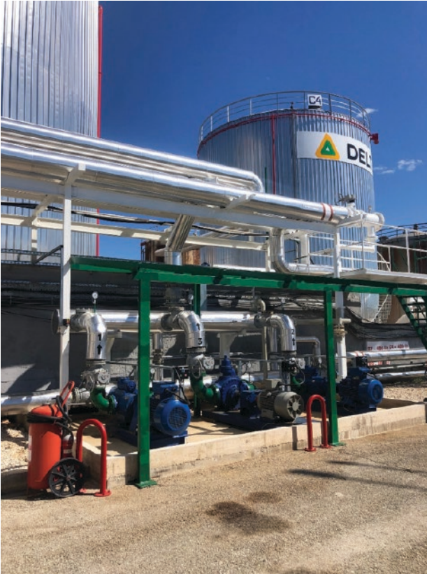
Slika 8. Pumpaona za prekrcaj palminog ulja
