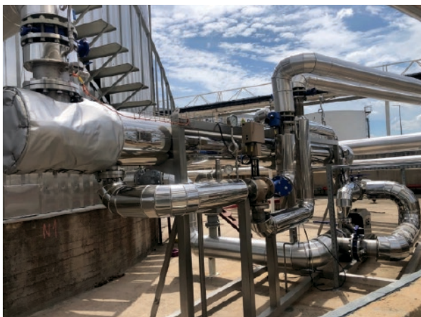
Slika 6. Izmjenjivači za grijanje palminog ulja
