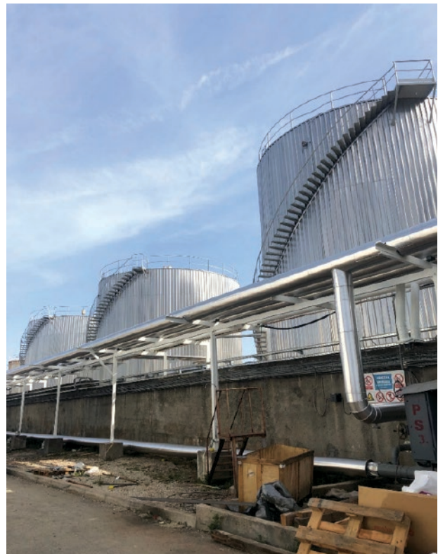
Slika 5. Izolirani spremnici za palmino ulje
