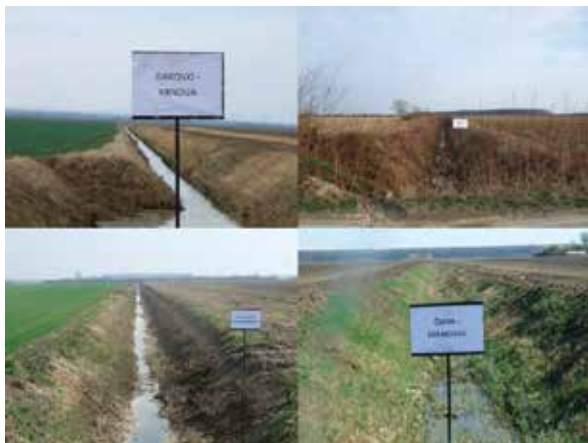
Slika 6: Fotografski prikazi (kao primjeri) dokaza stanja obnovljenih melioracijskih kanala III. i/ili IV. reda (Izvor: „Drenaža zemljišta Hrvatske“, Petošić, 2021.).
