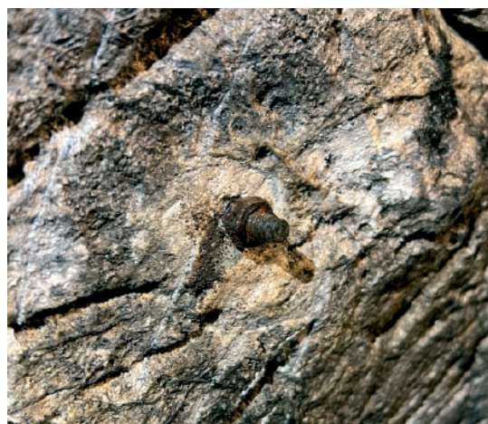
Slika 4. Korodirani sidrišni vijak u Gospodskoj špilji Autor: Mirna Šandrić
