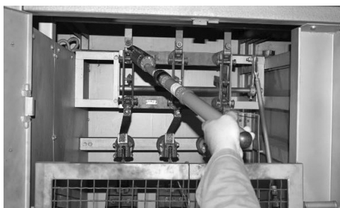
Slika 12: Pravilan način ispitivanja visokog napona
