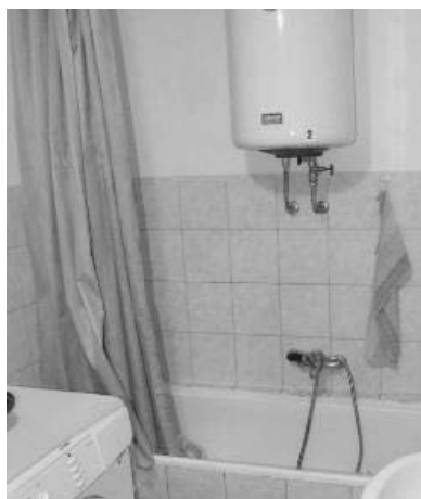
Slike 8 i 9: Električni bojler u kupaonici i neispravan grijač
