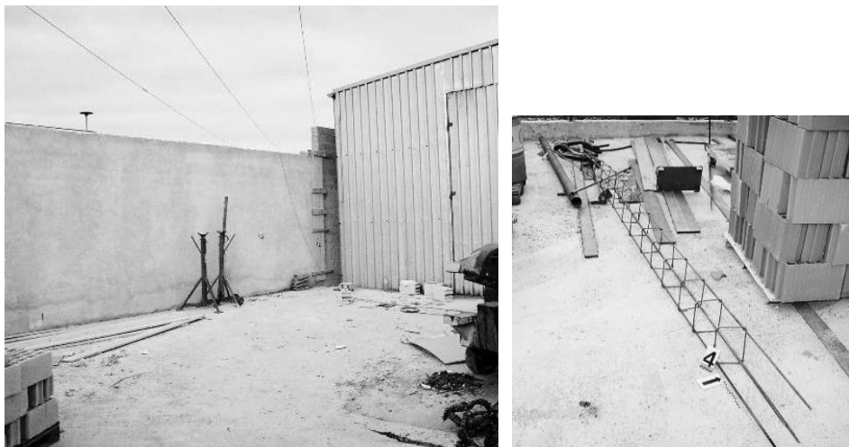
Slike 13 i 14: Betonski zid na gradilištu u blizini DV 110 kV i metalna armatura
