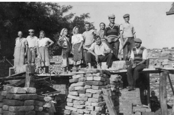
Sl. 8. Majstori i mještani na izgradnji nove školske zgrade u Gornjoj Šumi 1960. godine (vlasništvo obitelji Tuba, Molve Ledine).
