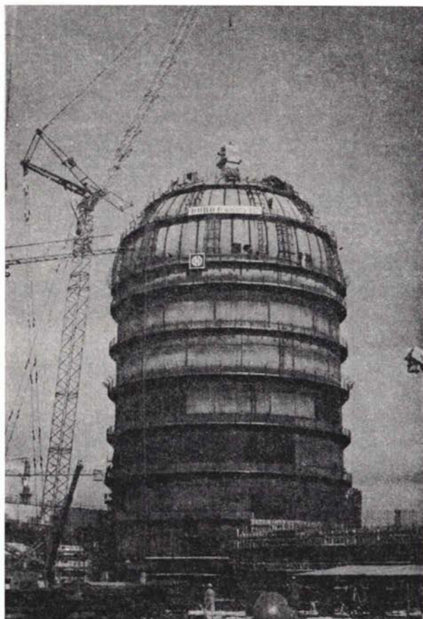
Sl. 3 Čelični kontejment na nuklearnoj elektrani Krško (snimio: D. Vojković, dipl. inž.)
