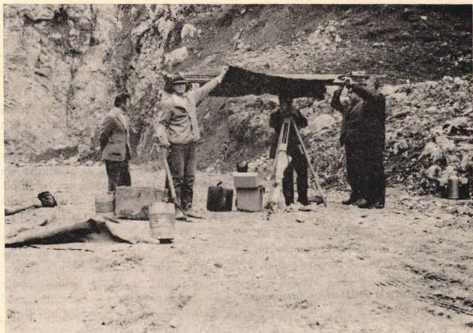
SI. 1 — Određivanje početka prelazne krivulje na ulaznoj strani tunela. Mjerenje dužine tangente distomatom DI 10.
