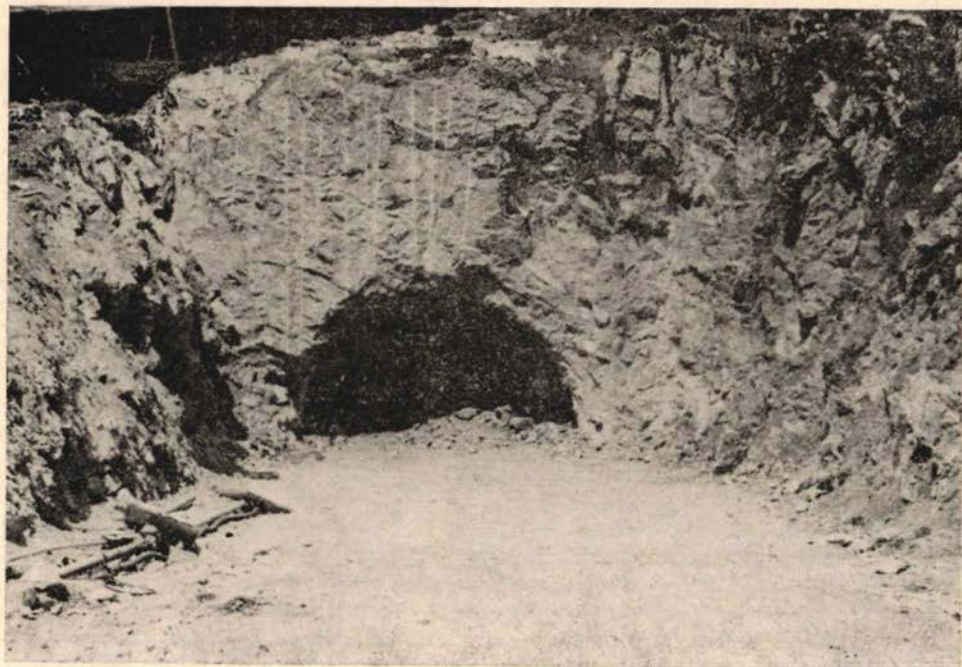
Sl. 3 — Pogled na portal tunela Učka u izgradnji s kvarnerske strane.
