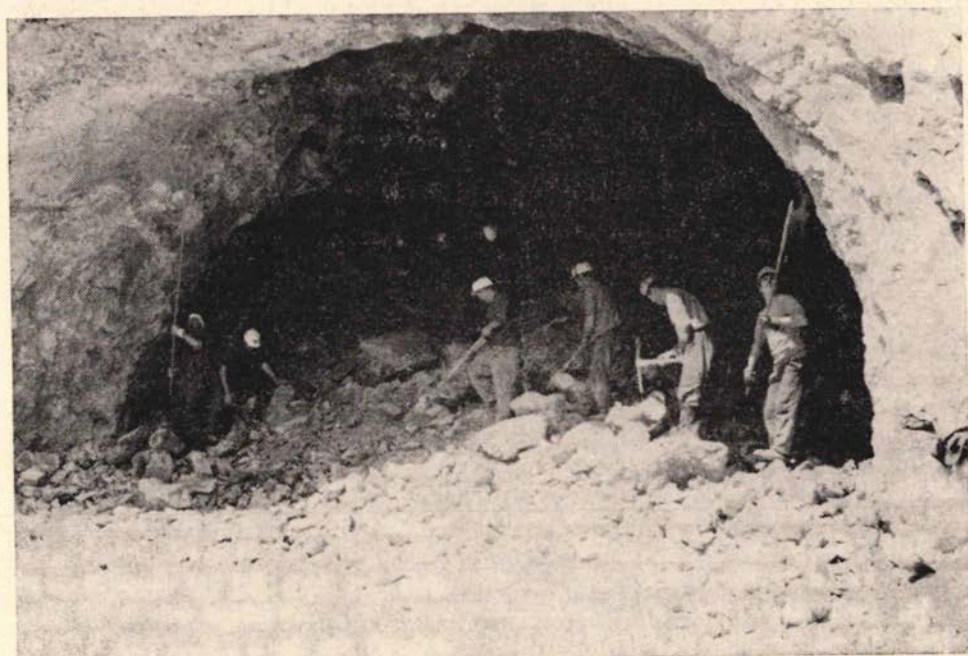
SI. 2 — Nakon što je otpucan profil tunela pristupa se čišćenju rubova i pripremi za oblaganje (torkretiranje)
