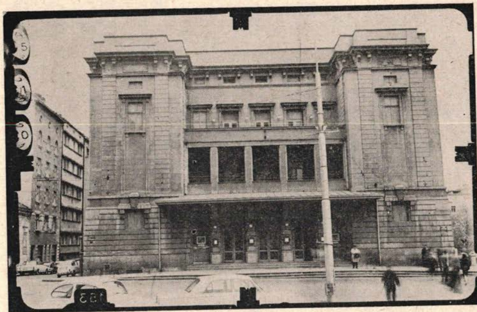
Slika 1 — Prednja fasada Narodnog pozorišta u Beogradu — Originalan plan raĀen u razmeri 1 : 50 na instrumentu Wild A—5. Snimanje i restituciju izvršio ing. S. MitiĀ i ing. S. TomanoviĀ — Zavod za fotogrametriju, Beograd. (Reprodukcija umanjena).
