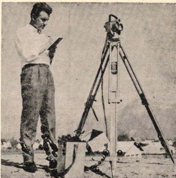
Slika 2. — Distomat DI — 10 sa vezom na mjerni dio
