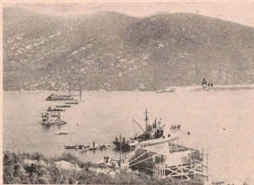
Sl. 2 — Postavljanje šipova za stupove
