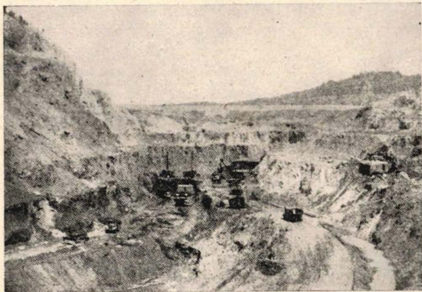
Sl. 1. Početni radovi na otvaranju jednog površinskog kopa
