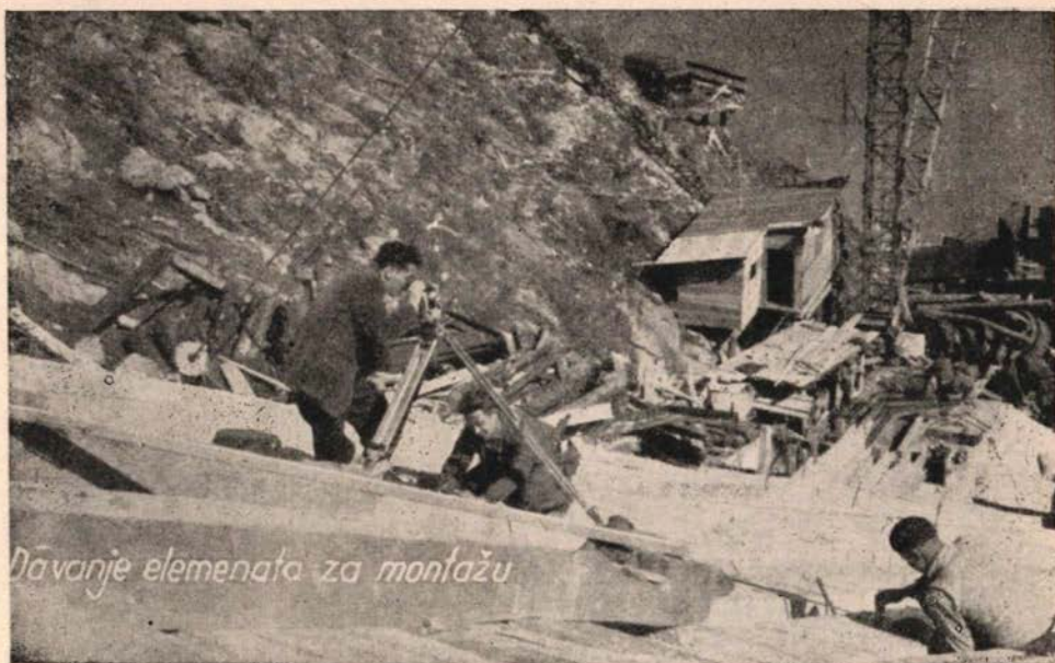
Sl. 13 — Davanje elemenata pri izvođenju radova kao i pri montaži na kosoj pruzi
