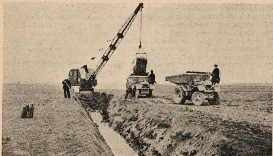
Sl. 5 — Bager na iskopu odvodnog kanala
