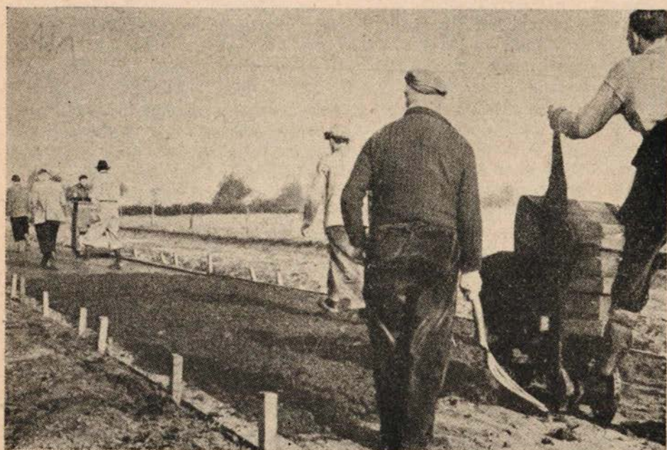
Sl. 6 — Gradnja asfaltirane ceste kroz komasacionu gromadu
