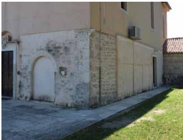
15. Župna crkva Sv. Ivana Krstitelja u Konjevratima, donji dio južne strane zapadnog pročelja i južnoga perimetralnog zida građevine (foto: Ivan Josipović)
