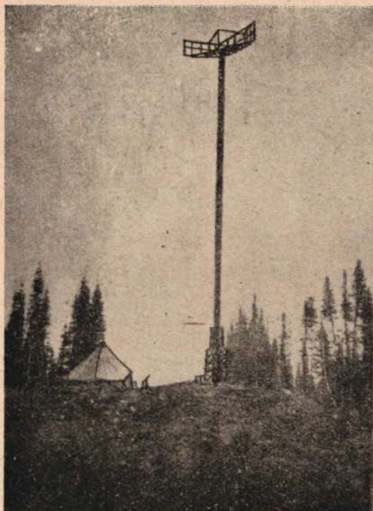
Sl. 3. Antena zemljišnog stajališta. Visina cca 17 m
