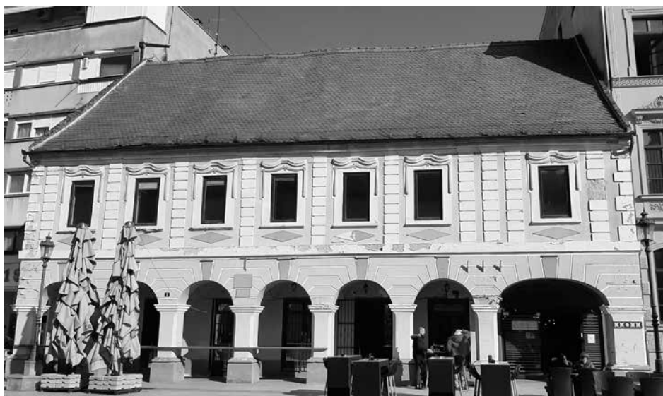
15. Kuća Margetić (Ul. kralja Zvonimira 2) Margetić house
