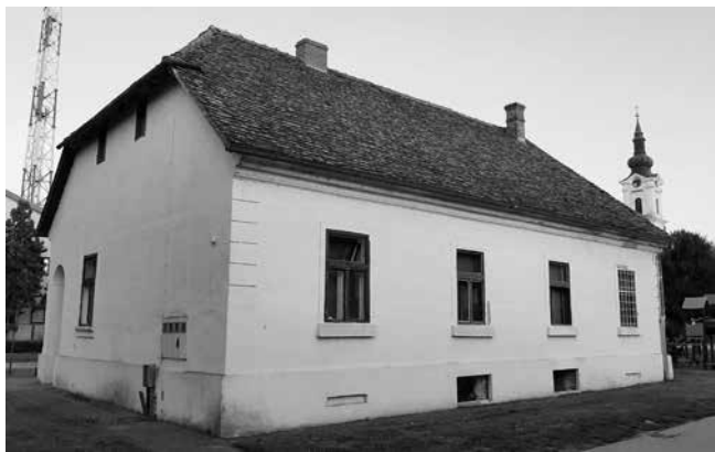
13. Kuća Čurilović (Ul. Vladimira Nazora 7) Čurilović house
