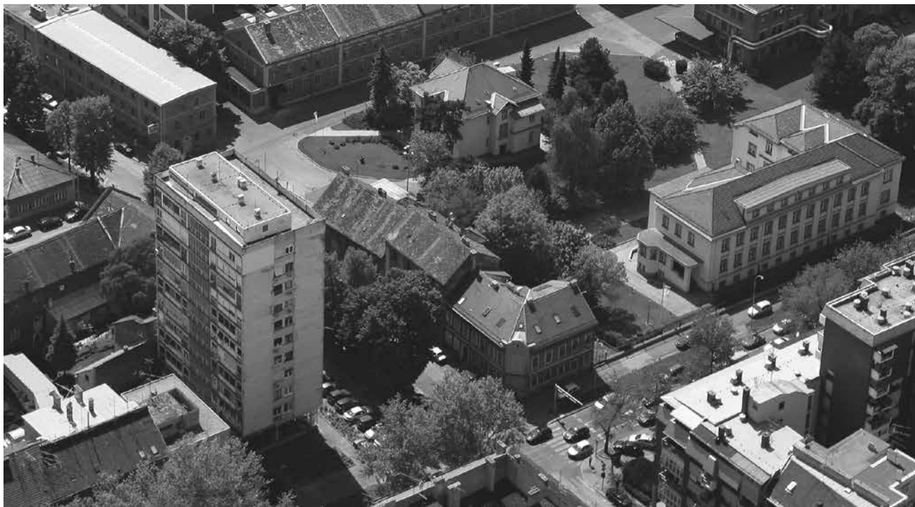
13. Aleksandar Bakal, neboder na jugoistočnom uglu Vodovodne i Ulice Ive Lole Ribara (danas Grada Mainza). Desno Franckove reprezentativne zgrade i očuvane parkovne površine oko njih: nova upravna zgrada Lava Kalde duž Prilaza baruna Filipovića (1923. – 1928.), kuća tvorničkog upravitelja Kune Waidmanna (1893./1894.) i glavna proizvodna zgrada Kune Waidmanna (skroz gore; 1892./1893.), fotografirano oko 2014. (MGZ, Fototeka)
