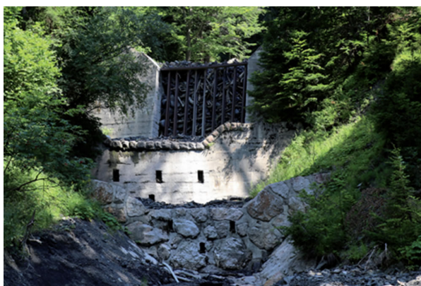
Slika 1 Sustav bujičnih barijera na bujici Suhelj u Kranjskoj Gori [14]
