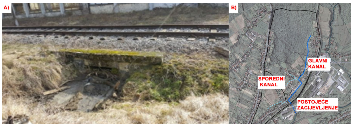
Slika 7 A) Ulaz u postojeće zacijevljenje, B) Idejno rješenje zone B Figure 7 A) Entrance to the existing culvert, B) Conceptual solution of zone B
