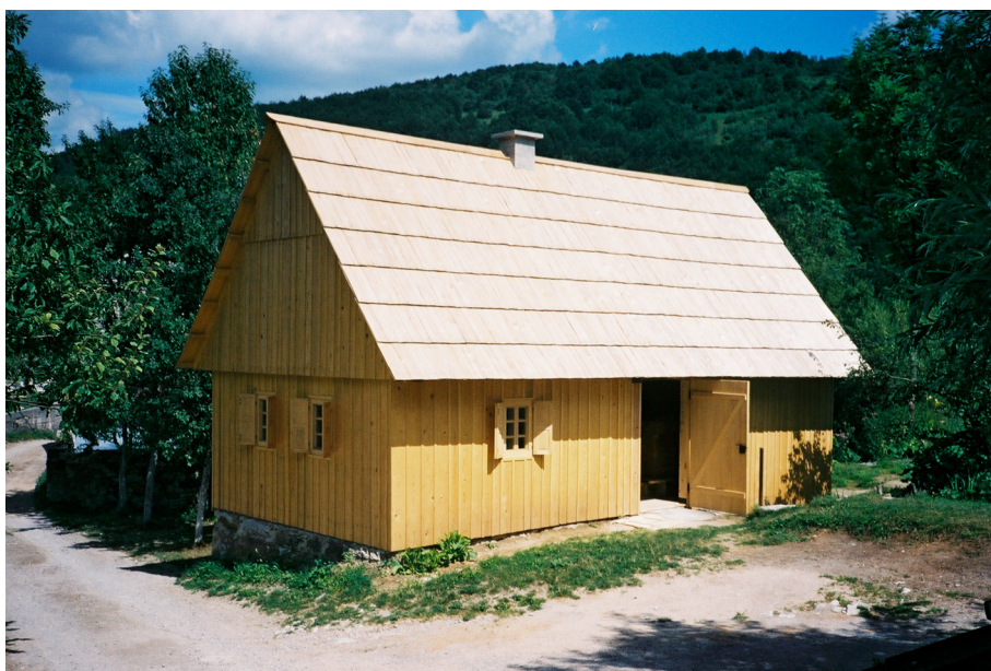
4. Zgrada mlina nakon obnove. Foto: A. Mlinar, 2003.
