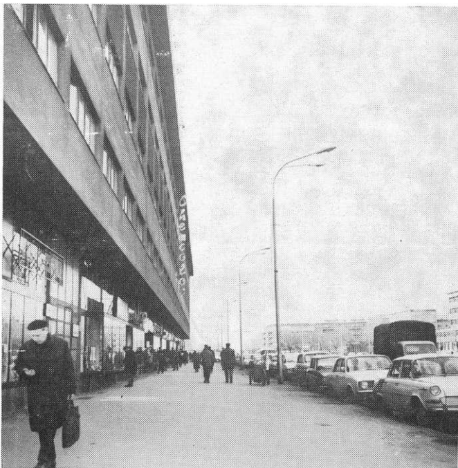
prostor ispred šegvićevog objekta u ulici proleterskih brigada
